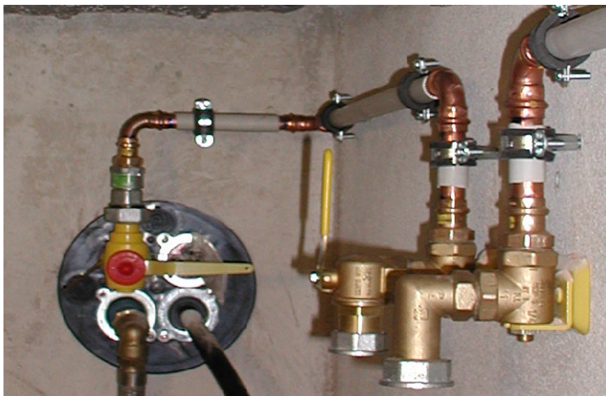
Anschluss einer Gaszähler-Anschlussplatte
