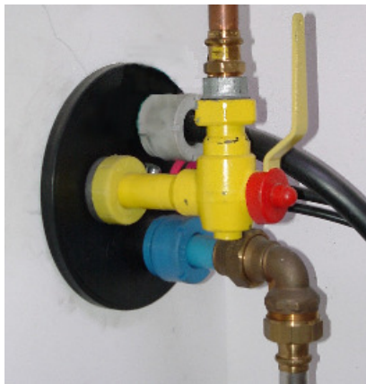
Beispiel: Mehrsparten Hauseinführung
