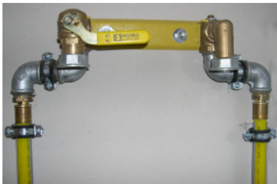
Gas-Zähleranschlussplatte – Anschluss mit nicht metallenen Leitungen
